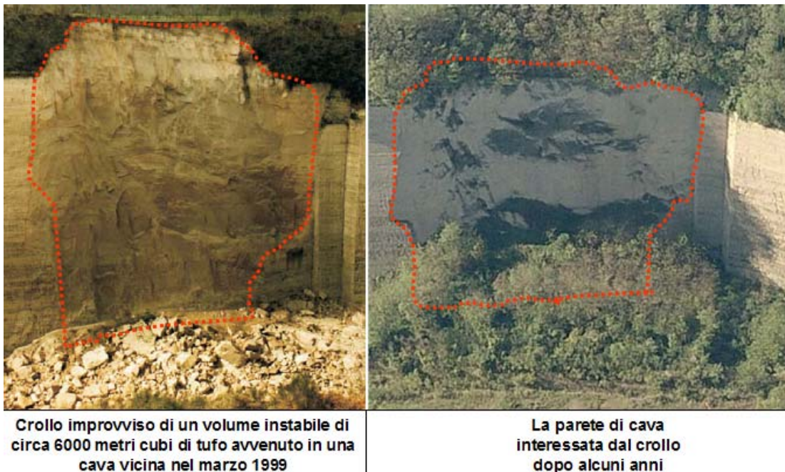
Figura 29: Il versante interessato dal crollo del marzo 1999 subito dopo l'evento (a sinistra) e dopo alcuni anni (a destra). E' evidente che il prisma tufaceo crollato aveva uno spessore di diversi metri e che il crollo ha interessato tutta la parete verticale. Nella foto a sinistra si notano, nella parte alta della parete, superfici di discontinuità immergenti a franapoggio meno inclinate del pendio, proprio come nella cava del Poligono
