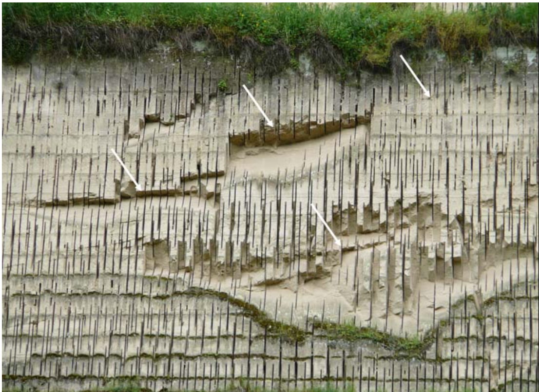
Figura 10: Evidenze dell'intensa fratturazione e dei prismi di tufo crollati negli anni scorsi dalla parete sudorientale. Le discontinuità tettoniche sono indicate dalle frecce bianche
